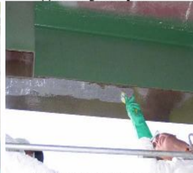
(d) Epoxy application on beam
