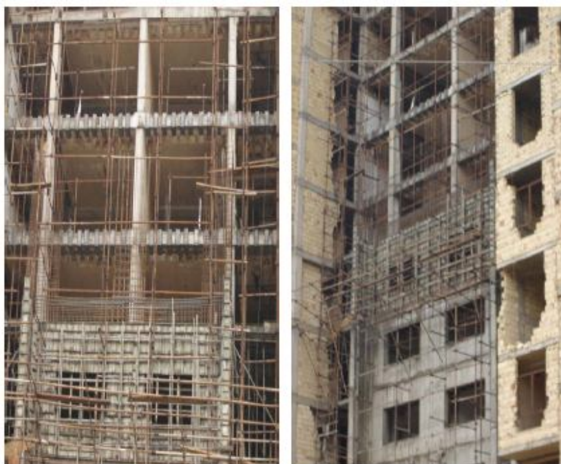
افزودن میانقاب بتنی به عنوان دیوار برشی
