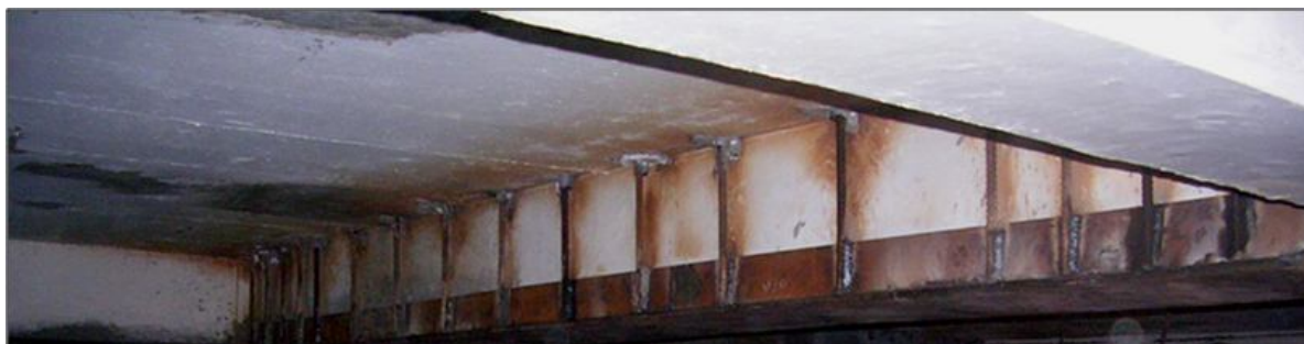
تقویت تیر بتنی با زره فولادی
