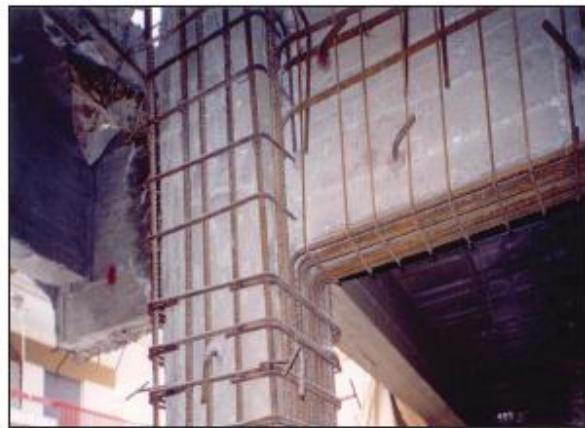
اجرای روکش بتنی در اطراف اتصال خارجی
