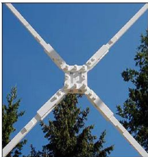
استفاده از میراگرهای اصطکاکی پال (Pall) در مقاوم سازی
