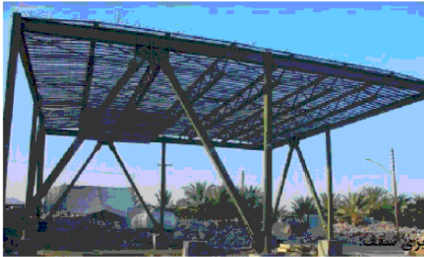
نصب روفیکس و شبکه میلگرد آن
