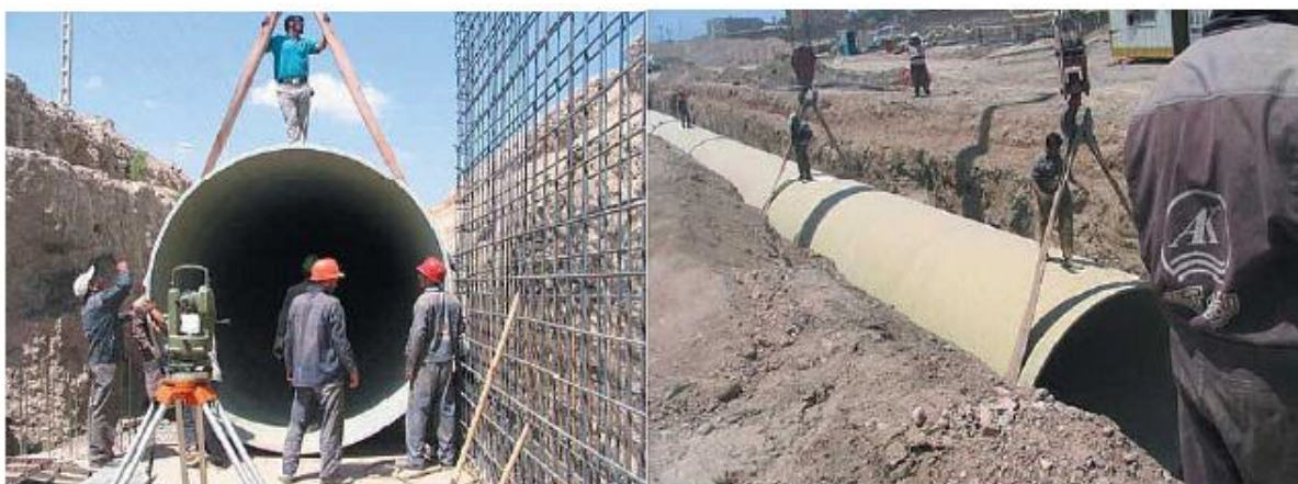
شکل ۱۰-۲- نصب تونل تاسیسات شهری از جنس فایبر گلاس (GRP)
