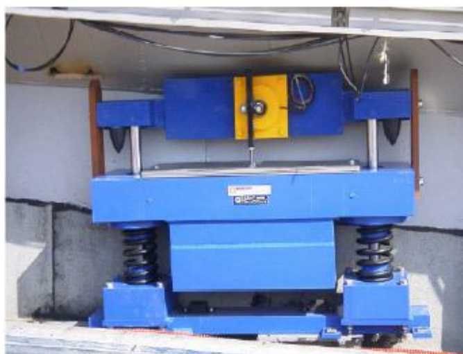
نمونه ای از استفاده میراگر جرمی در پلها
