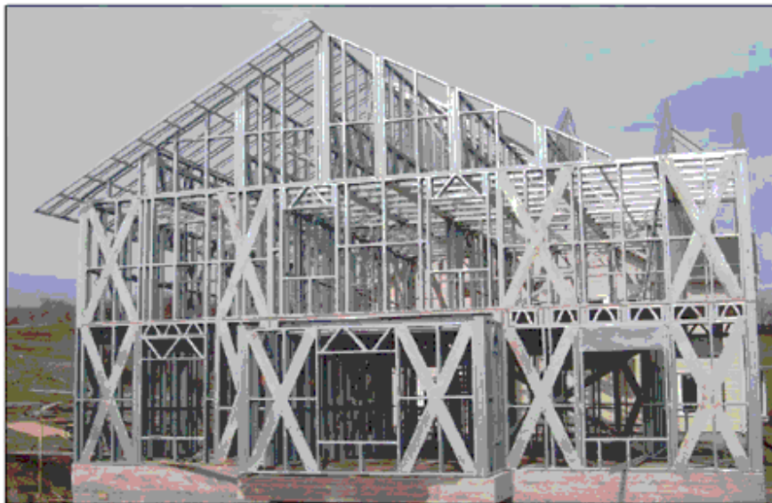
سیستم LSF مهار جانبی شده با بادبند ضربدری
