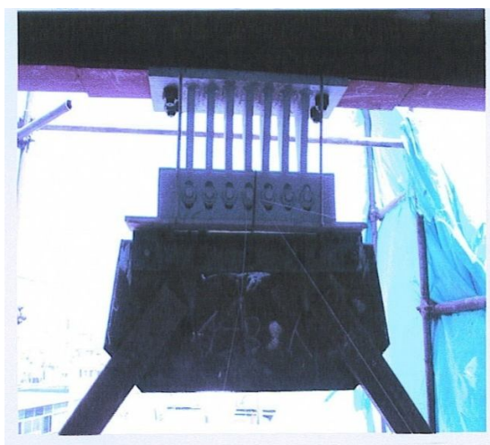
میراگرهای TADAS
