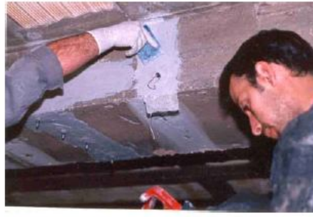
شکل ۱۲- درزگیری سطح ترک با رزین اپوکسی ویژه
