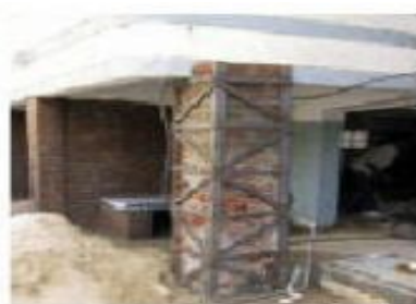
تقویت دیوار آجری بانبشی
