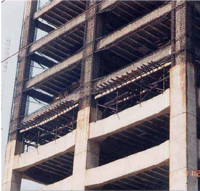
تقویت قاب بتنی ( تیر و ستون بتنی) با زره پوش بتنی
