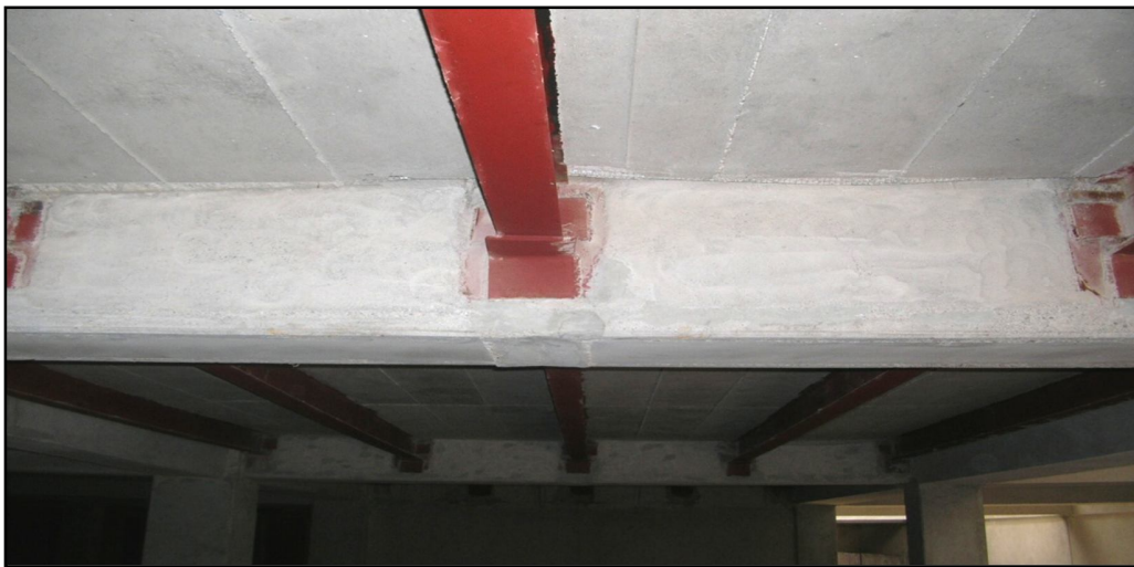
اضافه کردن تیرهای فولادی زیر دال
