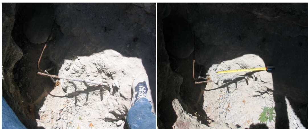
نمونه برداری از میلگرد جهت تعیین مشخصات آن
