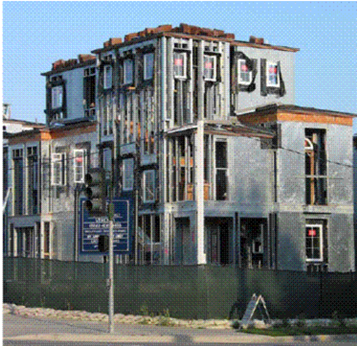
سازه با دیوارهای برشی ورق فولادی
