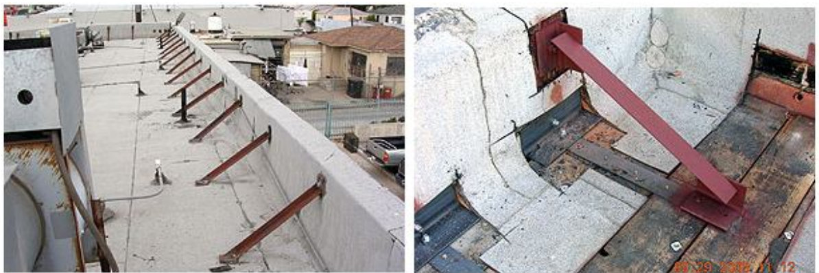
مهار نمودن دیوار جانبی
