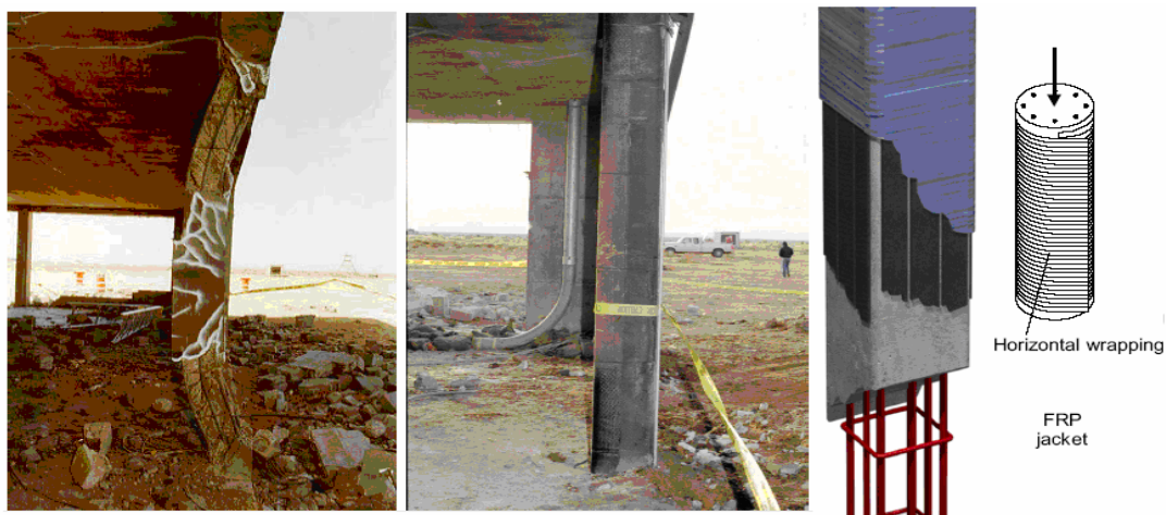
شکل ۸-۱۷. ستون تقویت شده با کاپوزیت FRP و آسیب دیده
