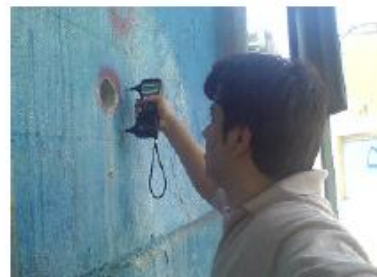
آزمایش تعیین مقاومت فشاری بتن دیوار کوله به وسیله تستر اولتراسونیک
