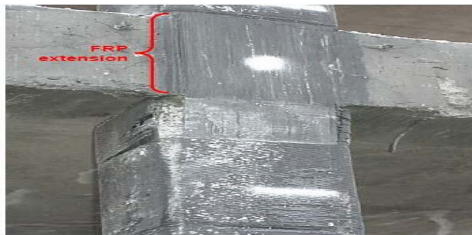
شکل ۸-۲۱. تقویت تیر به ستون
