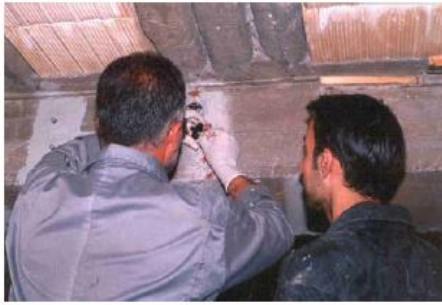
شکل ۱۱- نصب روزنه های سطحی تزریق
